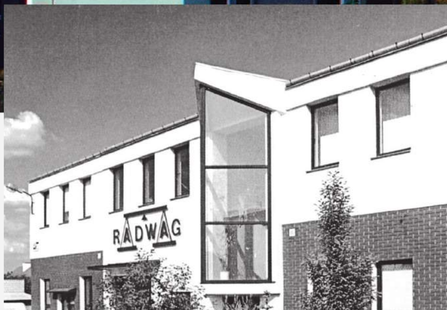
Pierwszy, własny budynek firmy RADWAG, rok 1994 RADWAG's first own building, 1994
